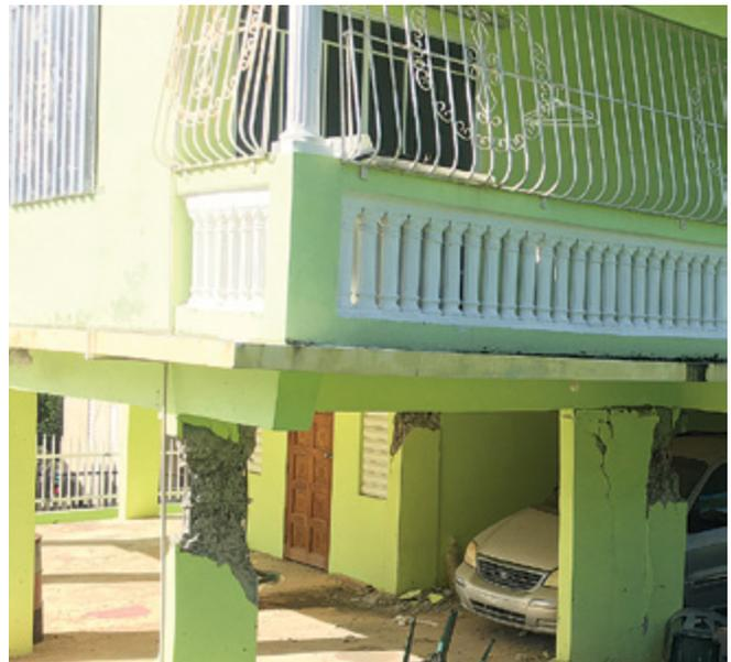
La foto 4 muestra fallos estructurales durante los recientes sismos. Observe el espaciamiento muy amplio de los aros de la columna y columnas muy esbeltas. Actualmente el mínimo según los códigos moderno es de 12” x 12” Vea las próximas fotos 5, 6, 7, y 8.
