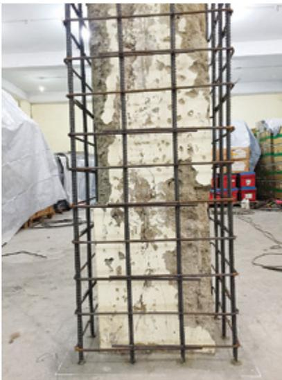
Figura 1. Vista de aumento de varillas de acero para ser recubiertas (fuente: internet)
