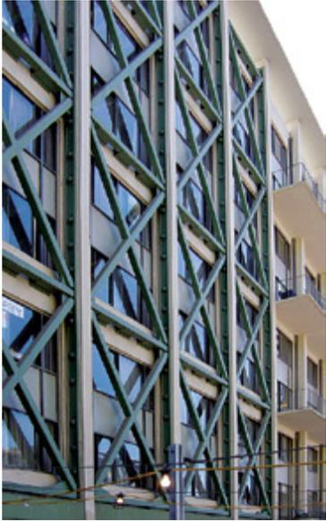
Figura 3. Ejemplo de colocar miembros en el exterior de la estructura (fuente: internet)
