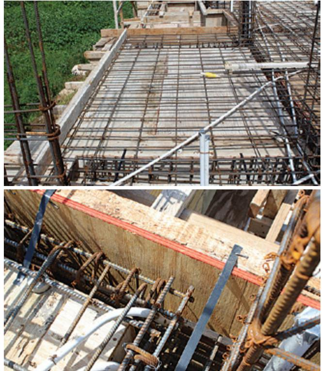
Las fotos 2 y 3 ilustran el acero colocado, inadecuadamente, en una losa con vigas en voladizo. Note en la segunda foto que los aceros de refuerzo negativo de las vigas no tienen continuidad hacia la columna y note la congestión del acero (Fuente: Ing. Alejandro Marrero).
