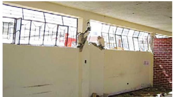
Figura 5. Ejemplo del efecto de la columna corta (fuente: internet)
